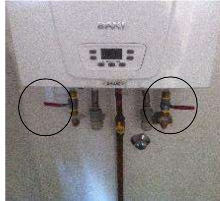
Llave de paso para agua de calefacción.
