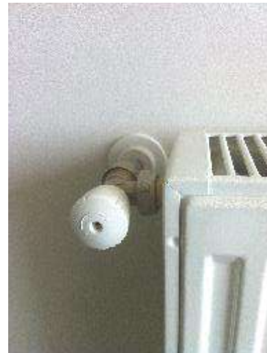
Llave de paso independiente de cada radiador
