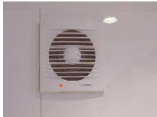
Los Extractores de Baños se activan y desactivan con el interruptor del baño.
