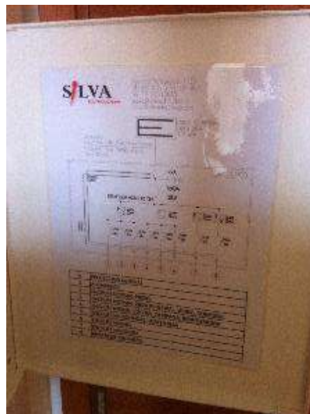
Inscripción de potencias y circuitos eléctricos.
